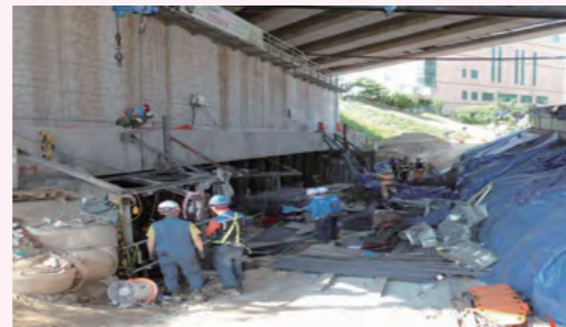
2016. 6. 1 사망4, 부상10 복선전철 현장 내 기존교량하부 문형 구조물 벽체 철근작업 (강재용단 중 누출된 LP가스 폭발)
