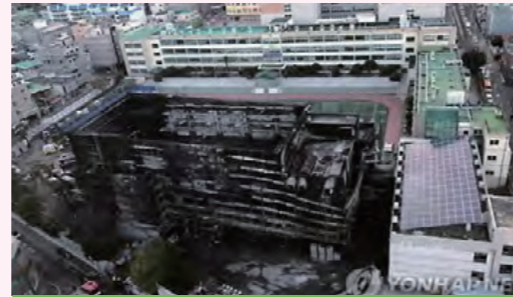
2017. 2. 12 사망1 학교 강당 및 급식실 증축공사 현장 내 외부 마감재 고정철물 용접작업 (용접불티가 단열재(발포 폴리스티렌)에 튀어 발화된 후 화재)
