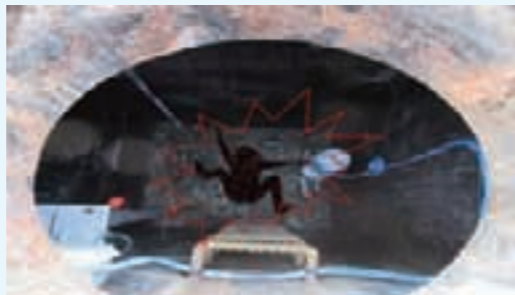
2017.05.18 사망 1명 맨홀 내 우수·우수 조절밸브 시험 가동 (작업자가 맨홀 내부로 내려가던 중 산소 결핍(추정)으로 인해 맨홀 하부로 추락)
